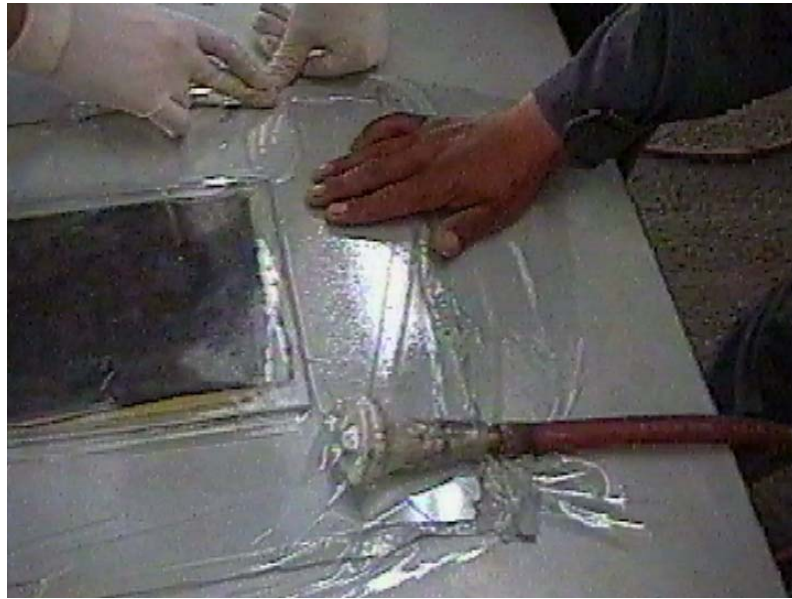
Figura 5-39: Extracción de aire de la bolsa de vacío
