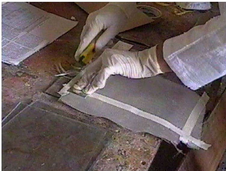
Figura 5-24: Corte de la tela de fibra de vidrio
