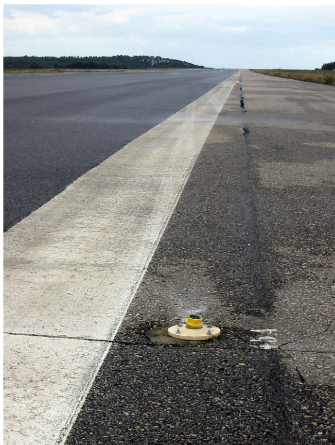
Figura 2. Daños producidos en la baliza de borde de pista
