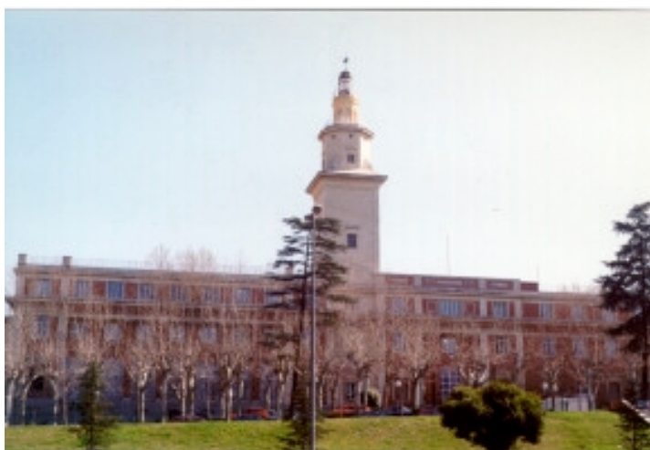
Figura 2.1.- Escuela Técnica Superior de Ingenieros Navales
